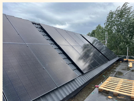
De werkzaamheden zijn in volle gang.
